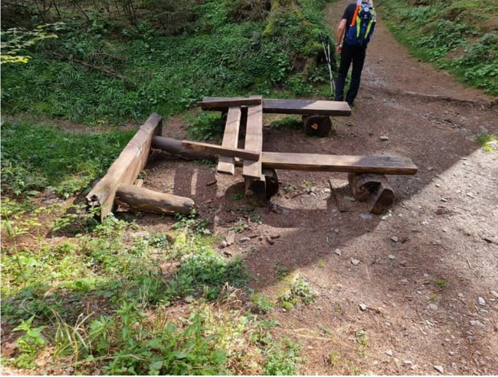
defekt und morsch, Rastplatz bei der Pechleite, schon fast ein "Dauerbrenner"
