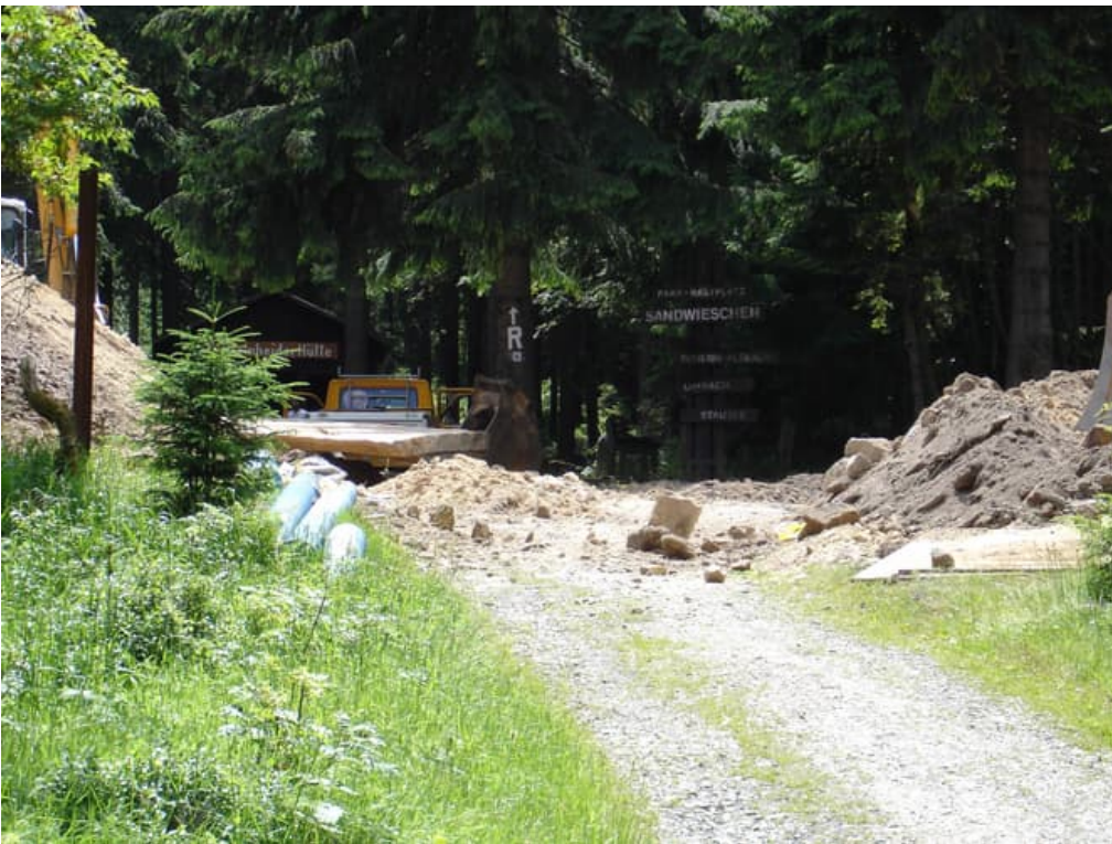
so könnte es am Sandwieschen bald wieder aussehen. Aufgrund des Umfangs der Arbeiten wird es auf jeden Fall zu eine Rennsteigsperrung während des Baugeschehens kommen
