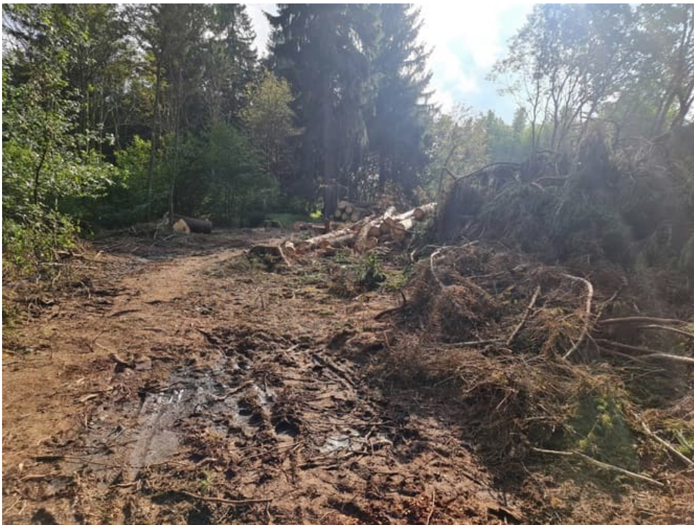
auch auf dem Herrnberg bei Neuhaus sieht es nicht viel besser aus, in der Nähe wird zusätzlich noch der Rennsteig wegen Baumfällarbeiten für die Erneuerung der Gastrasse bis Limbach gesperrt
